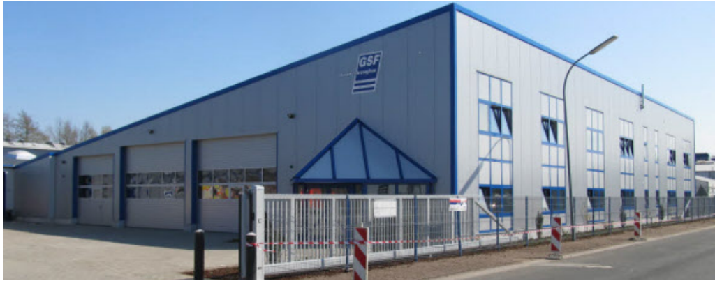
In Twist wurde die neue Halle errichtet.
